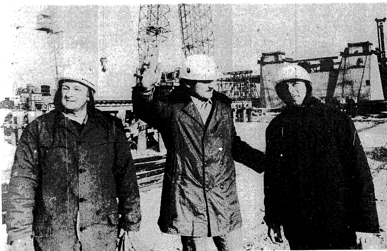
Na budowie Trasy Toruńskiej — największej inwestycji komunikacyjnej stolicy w bieżącym pięcioletniu. Od lewej: Jerzy Bombol — brzdajista mon-tażu, inż. Marek Marciniak — kierownik budowy mostu od „strony warszawskiej”, Jerzy Rykiel — brzdajista mostu, w Warszawie. Fot. S. ZUBCZEWSKI
