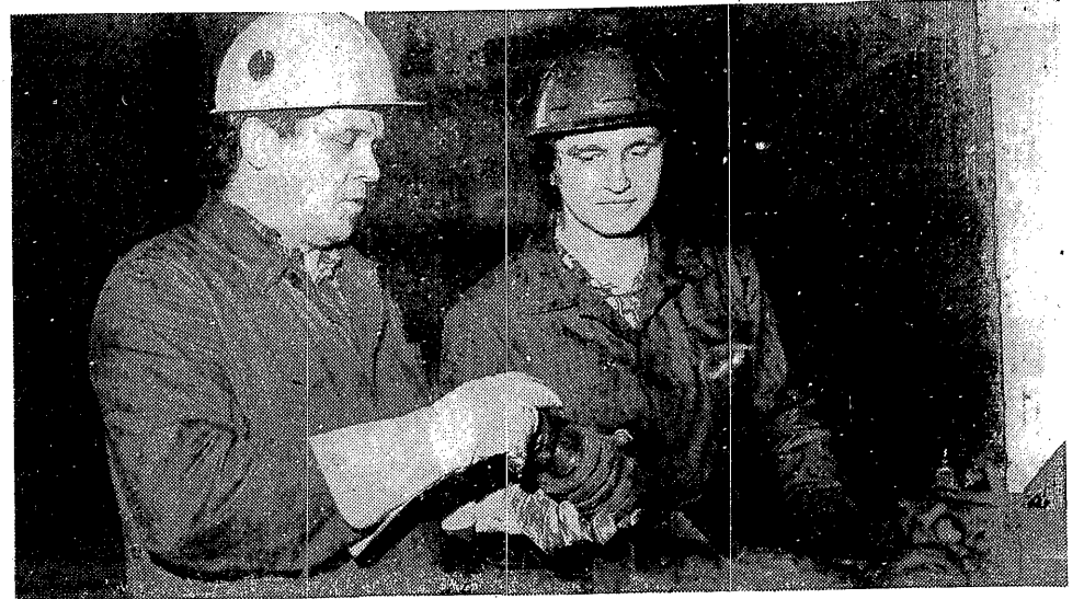
Większości elektrowni brakuje fachowców. Na zdjęciu: Mieczysław Niemalec i Edward Rębelski przy pracach remontowych w elektrociepłowni „Żerań”.
