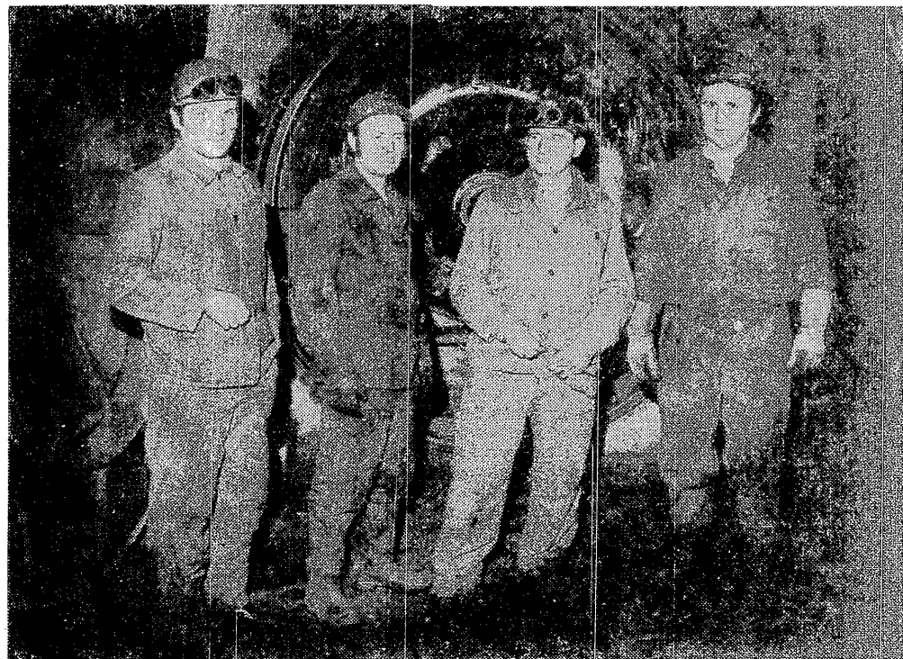
— Dla remontowców w elektrowniach gorący czas. Na zdjęciu (od prawej) Tadeusz PERCZYŃSKI — brzojadziwa, Jerzy WOLSKI, Roman DRZĄGOWSKI i Jerzy PIĘTKOWSKI z Elektrocieplowni „Żerów” przy naprawie kotła węglowego. Fot. S. ZUBCZEWSKI
