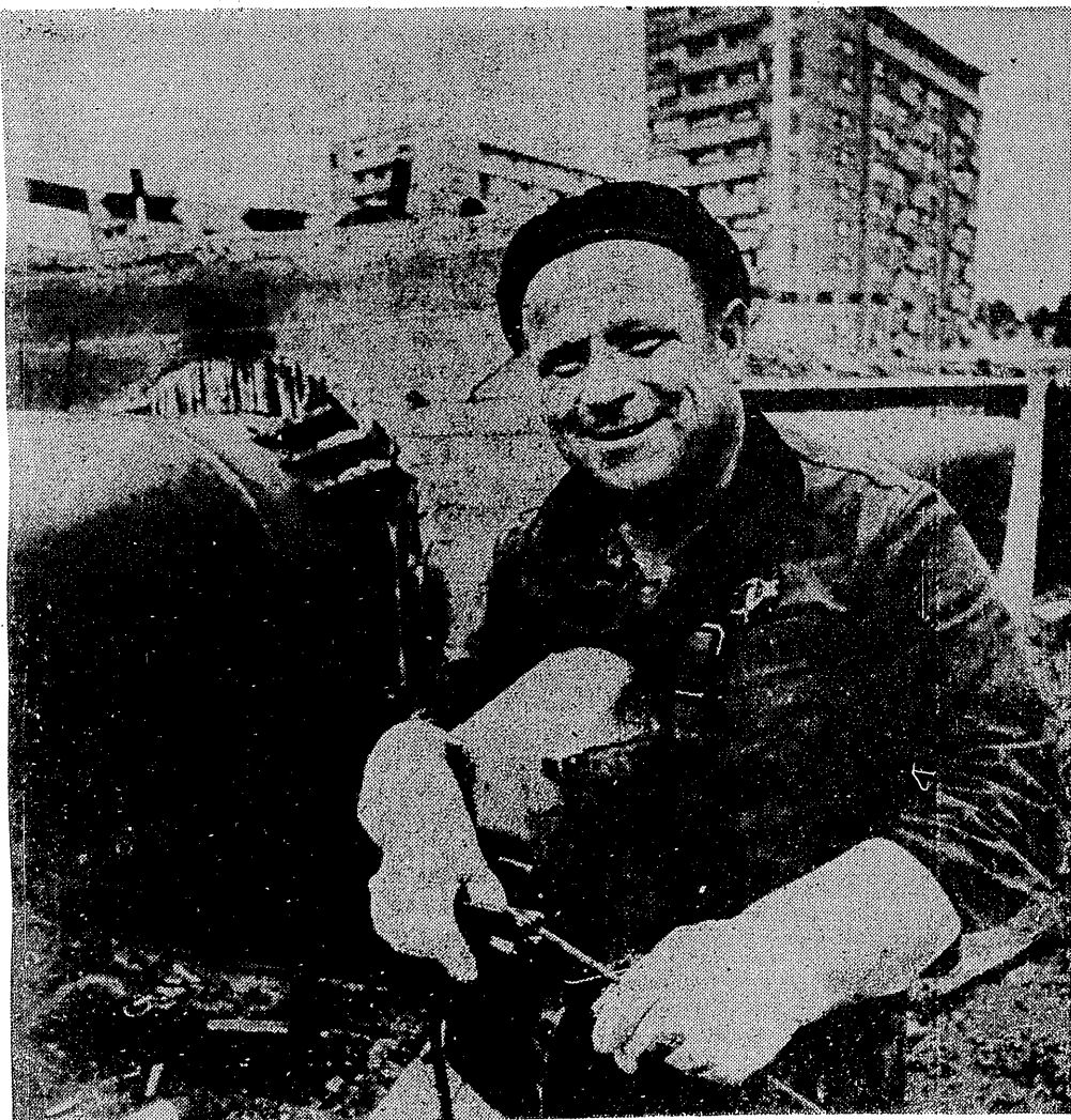
Czy przewody naziemne są szansą dla budownictwa (artykuł na str. 7)? Na zdjęciu: Leszek Burzyński — spawacz z Przedsiębiorstwa Budowy Sieci Ciepłych w Warszawie.
