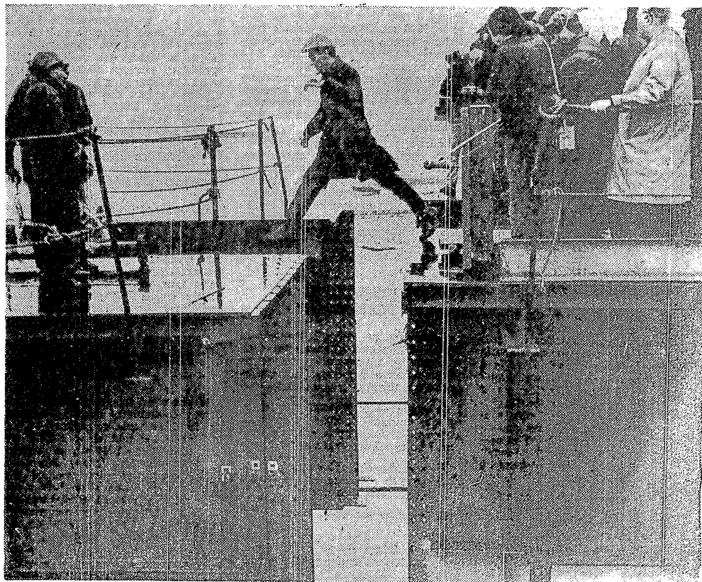
Za chwilę połączą się ostatnie przęsła Mostu Łazienkowskiego...
