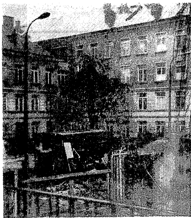
Firma remontująca szpital na Niekańskiej do konkursu „do-ro” nie staje. Zdjęcia: S. ZUBCZEWSKI
