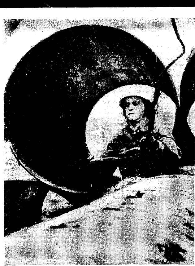
W Policach trzeba ułożyć i zmontować dziesiątki tysięcy ton rur.
