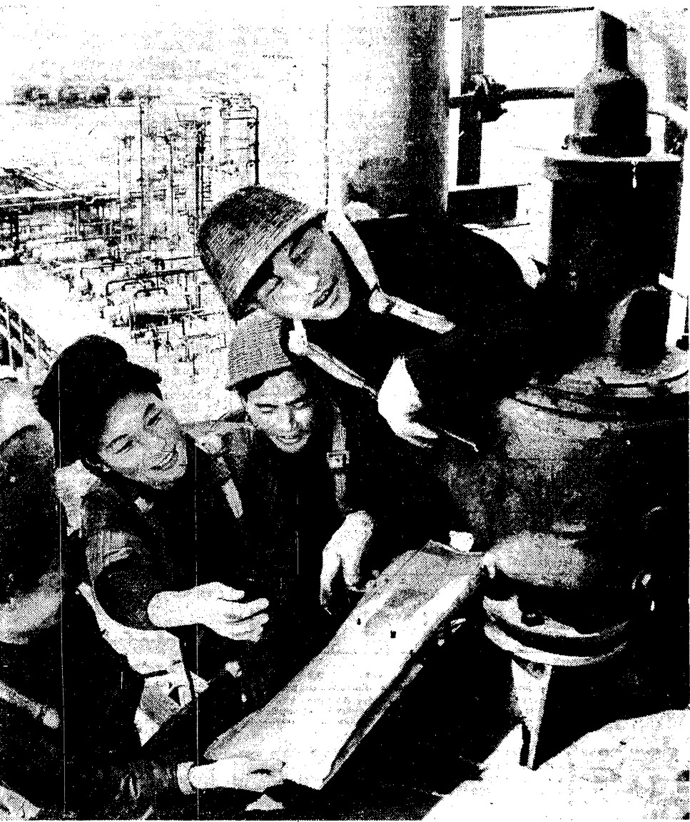
Jednym z głównych zadań koreańskiego przemysłu chemicznego jest zwiększenie produkcji nawozów i środków ochrony roślin. Na zdjęciu: na budowie nowego kombinatu k. Phenianu. Fot. CAF
