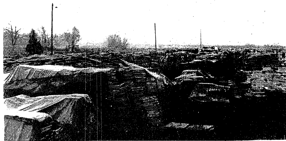
Martwy sezon na budowie drogo kosztuje. Te ocieplające płyty, importowane z NRD, nie nadają się już do użytku.
