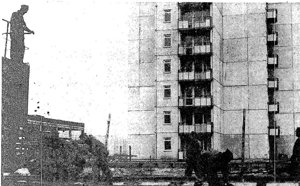
Żołnierze od dawna współuczestniczą w budowie warszawskich osiedli mieszkaniowych. Pomagają m.in. wznosić budynki na Ursynowie.
