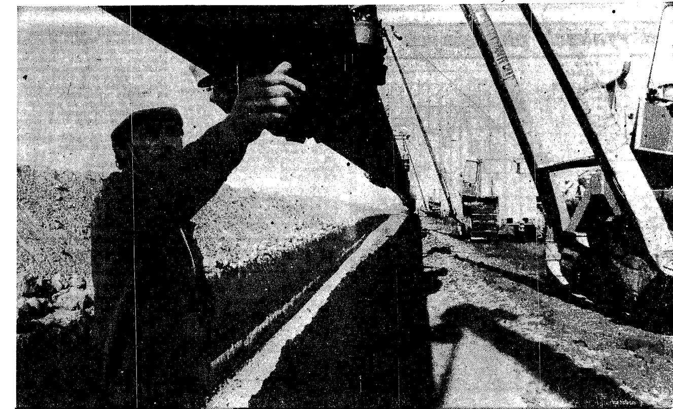
Układanie „polskiego” odcinka rurociągu orenburskiego zbliża się do końca.
