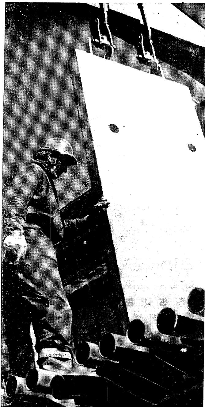
Praca budowlanych jest uważana powszechnie za trudną, ciężką i brudną. Fot. M. STANKIEWICZ
