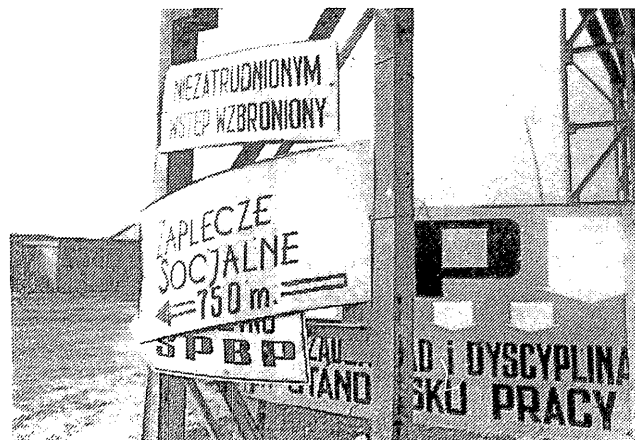
Zaplecze socjalne wprawdzie daleko — ale dobrze zorganizowane.
