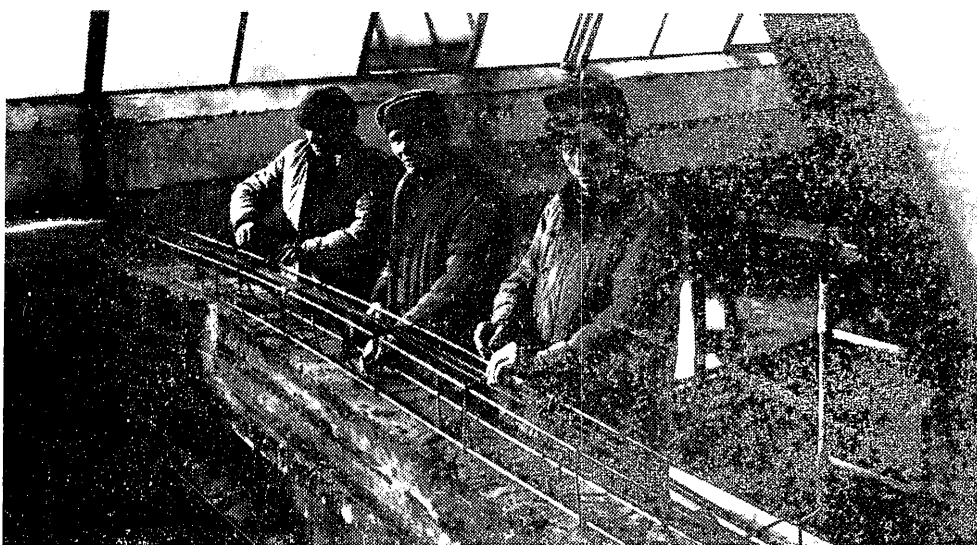
Prace zbrojeniowe w nowo budowanym wydziale maszyn do pisania w Gołębiowie. Stoją od lewej: Józef Antos, Tadeusz Galiński, Stanisław Kądzierski
