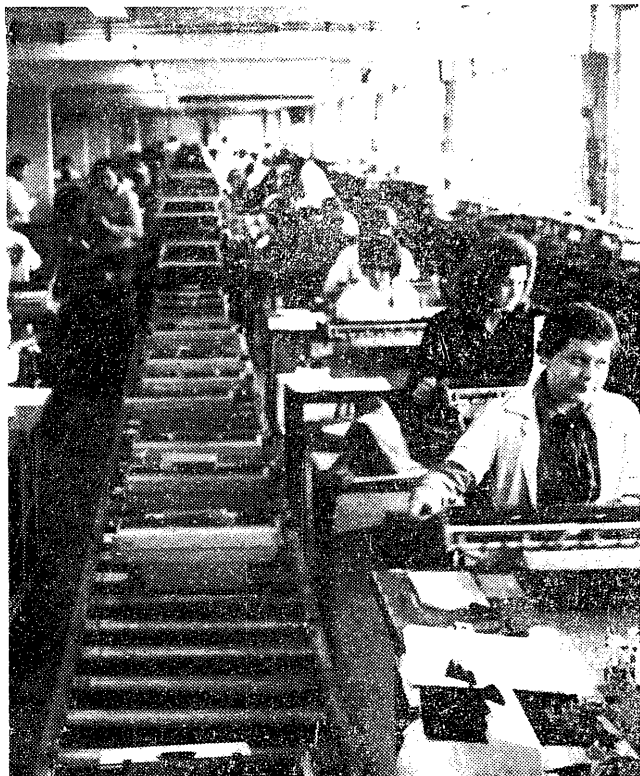
Hala montażowa ręcznych maszyn do pisania
