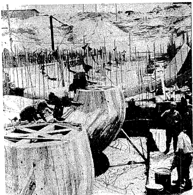
Na dziesiątkach placów budowy kozińskiego giganta dzięki wolnym sobotom praca idzie sprawniej i szybciej. Foto CAF
