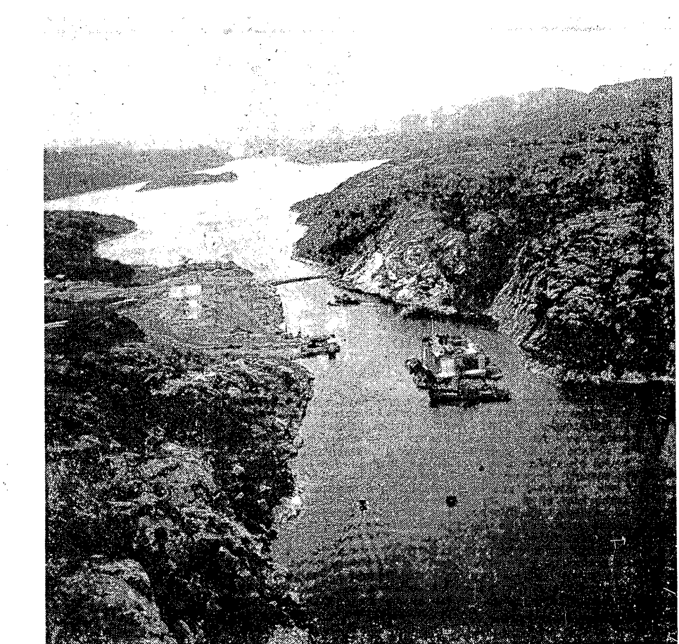
Nad Morzem Barentsa powstaje pierwsza w ZSRR doświadczalna elektrownia wykorzystująca energię przypływów morskich o mocy 800 kilowatów. Na zdjęciu: W Zatoce Kisłaja na jej przemyśle instaluje się pływający blok, na którym zostaną zmontowane agregaty elektrowni. Foto: APN
