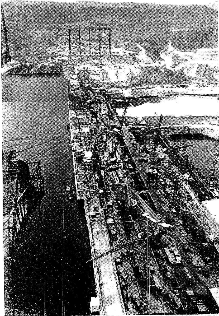
Na budowie Krasnojarskiej Elektrowni Wodnej
