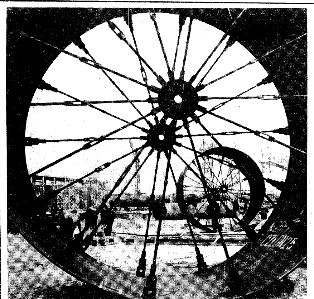
Na budowie zakładu wzbogacania piasków żelazistych w Zabcu.
