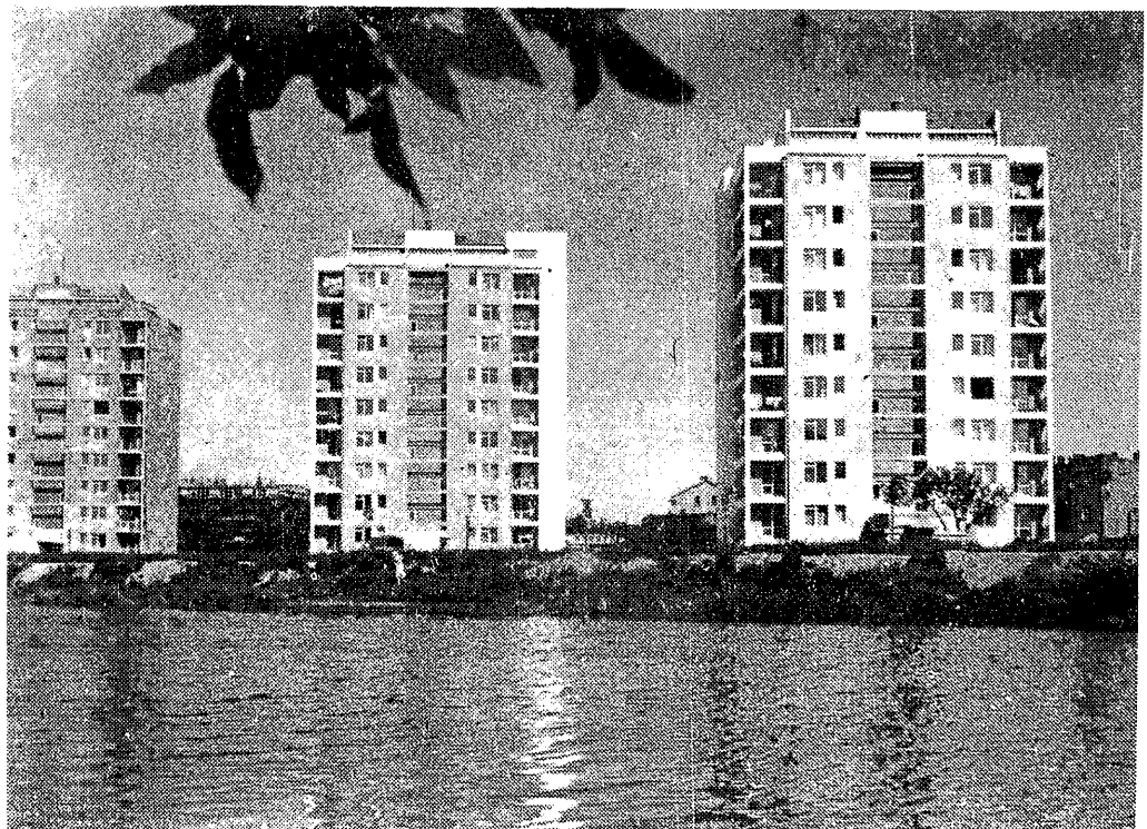
Nowe budownictwo na Wybrzeżu Gdańskim.
