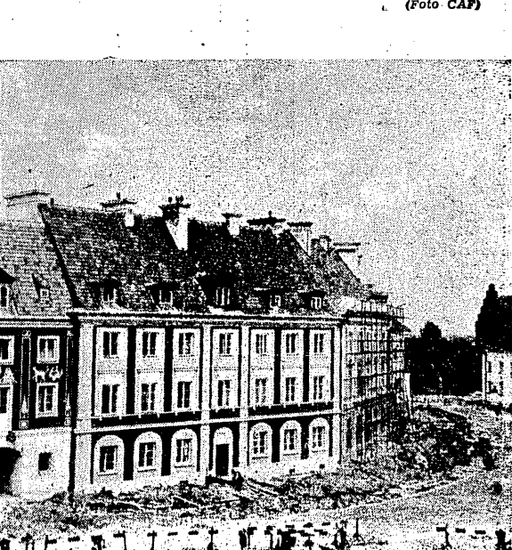
Prace wykończeniowe na Rynku Nowomiejskim w Warszawie (Foto CAF)
