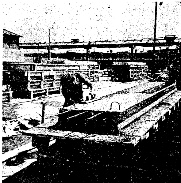
Zakłady prefabrykowane w Łęgu koło Krakowa (Foto CAF)
