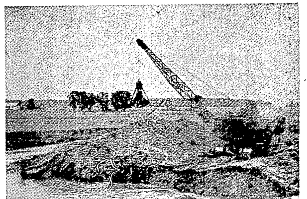
Na budowie kanału Wleprz-Krzna. Praca w okolicy wsi Borowice koło Krąsegostraw. (Foto CAF).
