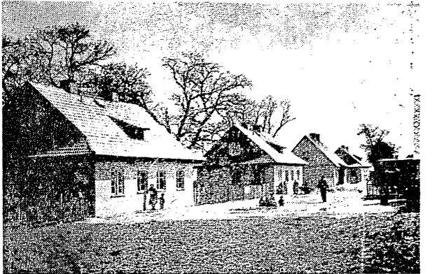
Nowe domki mieszkalne dla pracowników stacji nasiennej-szkółkiarskiej w Autotcie woj. poznańskiej. (Foto CAF).
