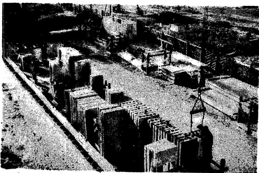
Wzorowo urządzone składowisko prefabrykatów na placu budowy.
