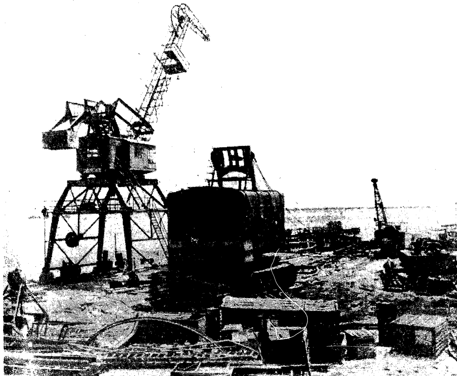
Montaż koparki elektrycznej o pojemności 7 m 3 na placu montażowym w Tachiasz. Koparki tego typu pracują przy budowie Głównego Kanału Turkmeńskiego.
