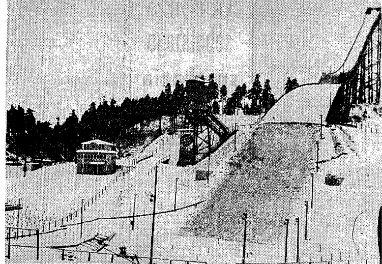
Skocznie stanowią część narciarskiego stadionu w Lahti. Fot. Archiwum „PS”
