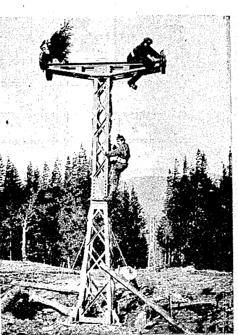
W połowie lutego ustawiono ostatnią, 17 podporę wyciągu krzeselkowego na Skryżynie. Fot. CAP
