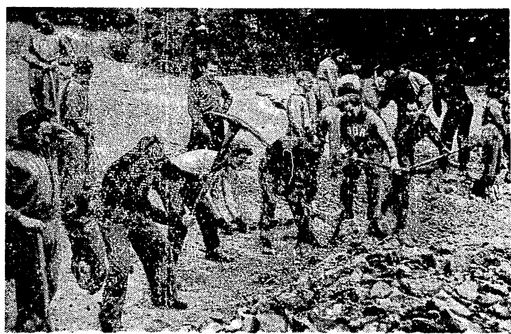
W poniedziałek 8 bm. reprezentacja lekkoatletyczna NRD wspólnie z zawodnikami i zawodniczkami polskimi wzięła udział w budowie socjalistycznej Warszawy. Sportowcy niemieccy pracowali kilka godzin przy budowie Parku Kultury na skarpie dawnego ogrodu Frascati (na zdjęciu). Wczoraj goście niemieccy byli na operze „Krabina”. Lekkoatletki NRD wyjechały do kraju we wtorek 9 bm. wieczorem, serdecznie żegnani przez młodzież sportową Warszawy.
