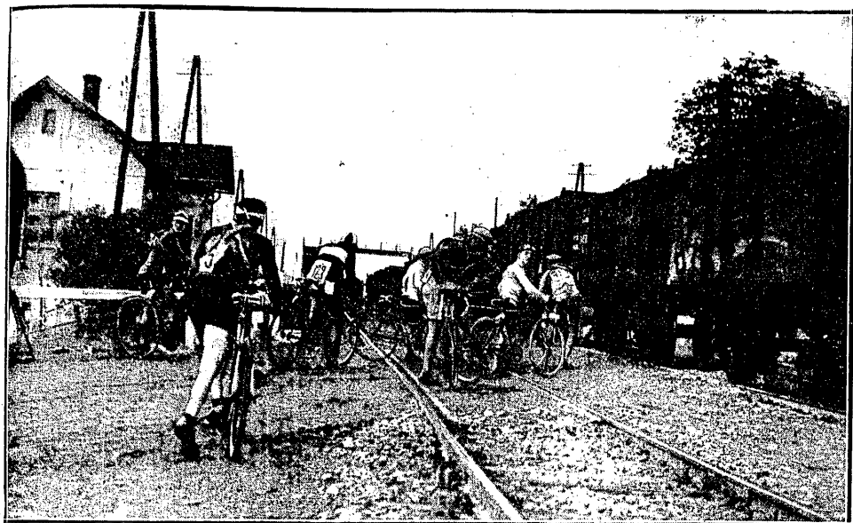
NA PRZEJEZDZIE KOLEJOWYM
