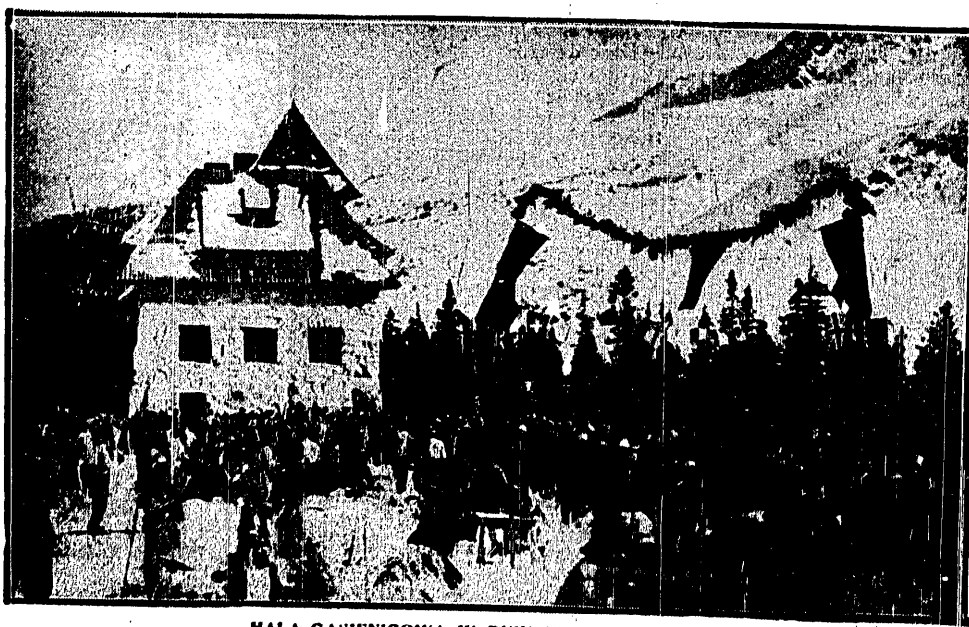
HALA GASIENICOWA W DNIE BIEGU ZJAZDOWEGO
