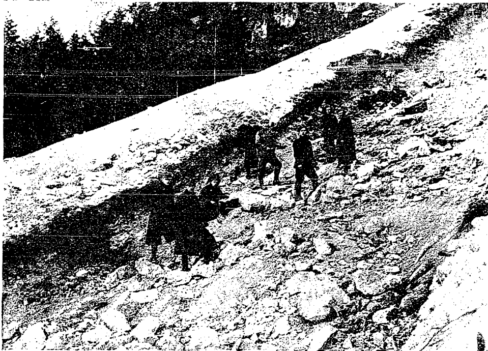
Z prac profilowych przy budowie skoczni na Krokwi.
